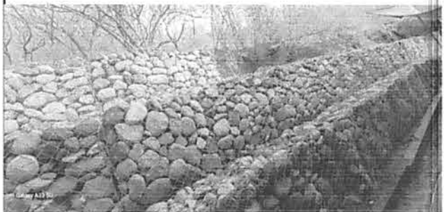
Foto 6: colocacion de gabiones en su tercer fila.
