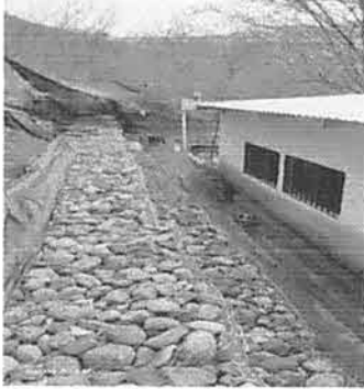
Foto 1: Se complementa la segunda fila de gabiones
