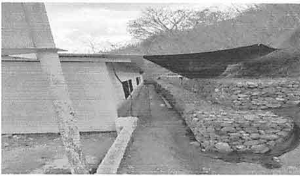
Foto 3: Se observa los gabiones .
