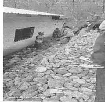
Foto 2: Llenado de gabiones .
